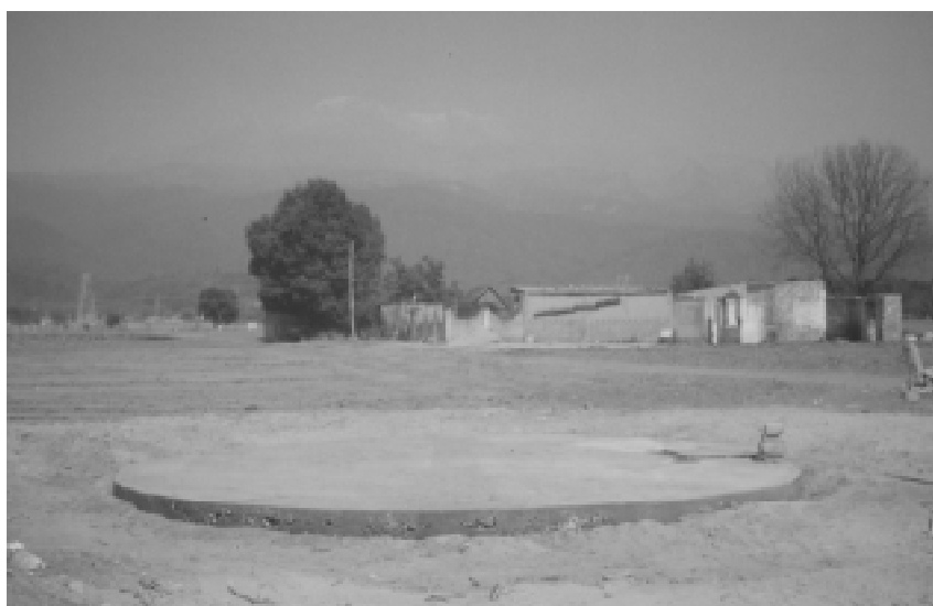
CITERNE D'EAU CONTRE L'ÉVAPORATION
