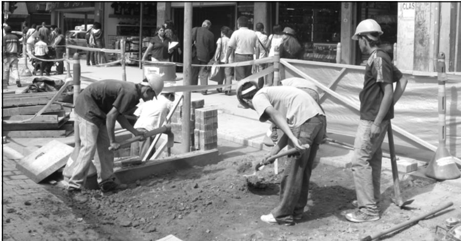
Travailleurs de la construction à Medellín.
